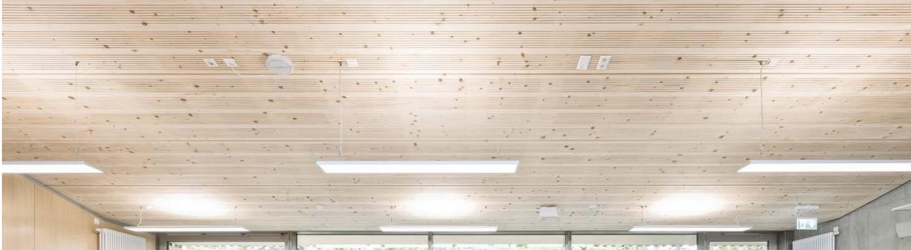
Ohne Einsatz von technischer Kühlung nur durch Ausnutzung der Bauteilmasse in Verbindung mit einer funktionierenden effektiven Nachtlüftung lagen am 24.07.2019 die Innenraumtemperaturen bei ca 24 °C – leider gab es kein Hitzefrei mehr!
