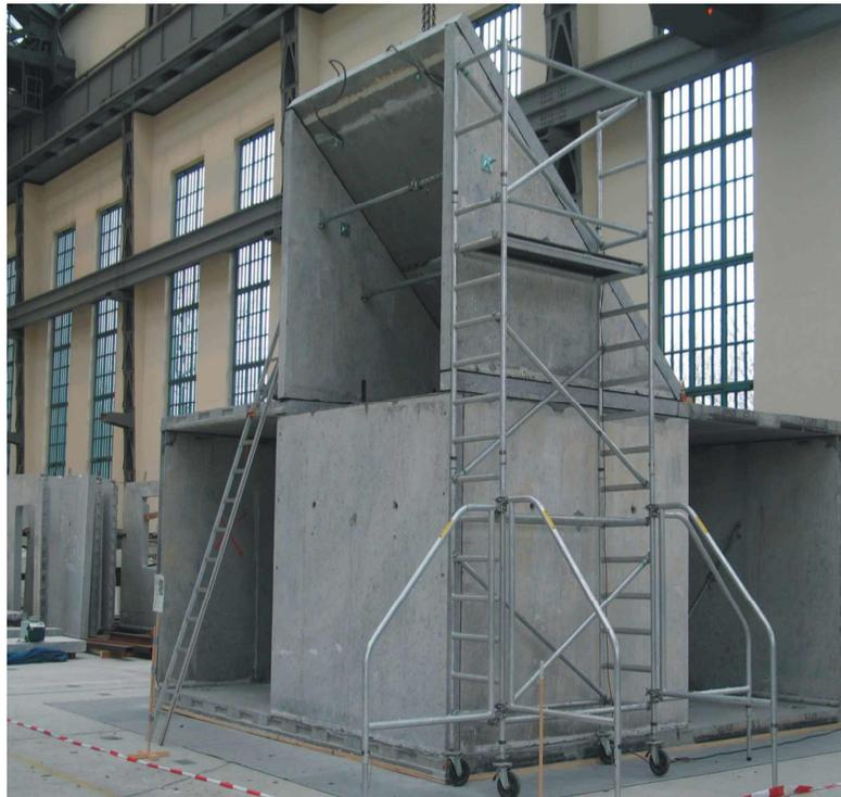
Realisierung eines Steildachs aus gesägten Decken- und Wandelementen.
